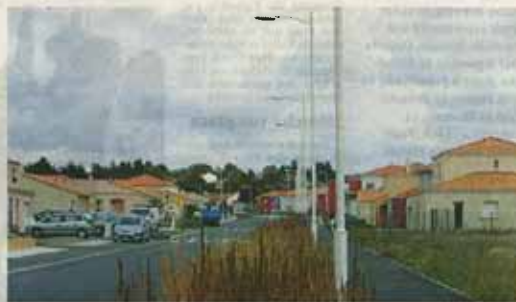
Le lotissement de la Durandière au Loroux-Bottreau possède des mâts électriques équipés de la fameuse collerette qui permet de moins éclairer la nuit.
